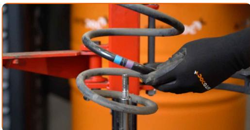
**37** Odstranite stari amortizer s kompresorja hidravlične spiralne vzmeti.
